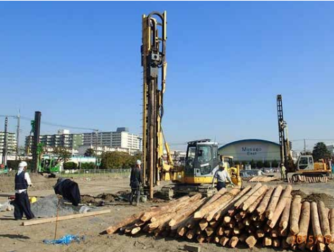
大型分譲住宅地（千葉県）
