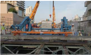
専用機械併用による床版撤去状況
